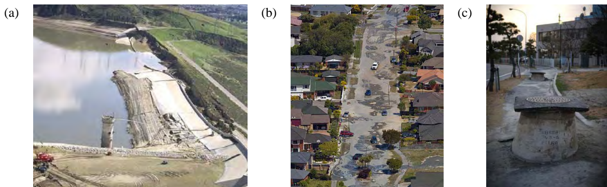
Figure 1. Effets de la liquéfaction lors des séismes de : (a) San Fernando (USA, 1971), (b) Christchurch (Nouvelle-Zélande, 2011), (c) Tohoku (Japon, 2011).
